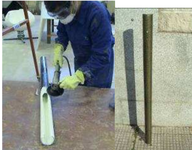
Reparación de botolón con fibra de carbono
