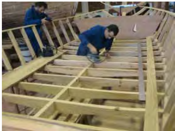
▲ Nivelado de picas
