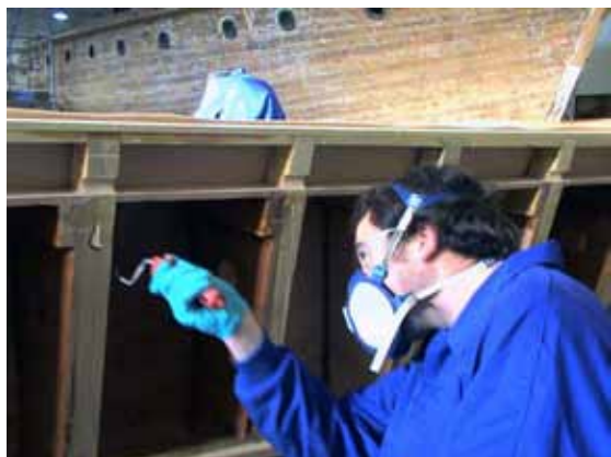
▲ Impregnación de cámaras estancas
